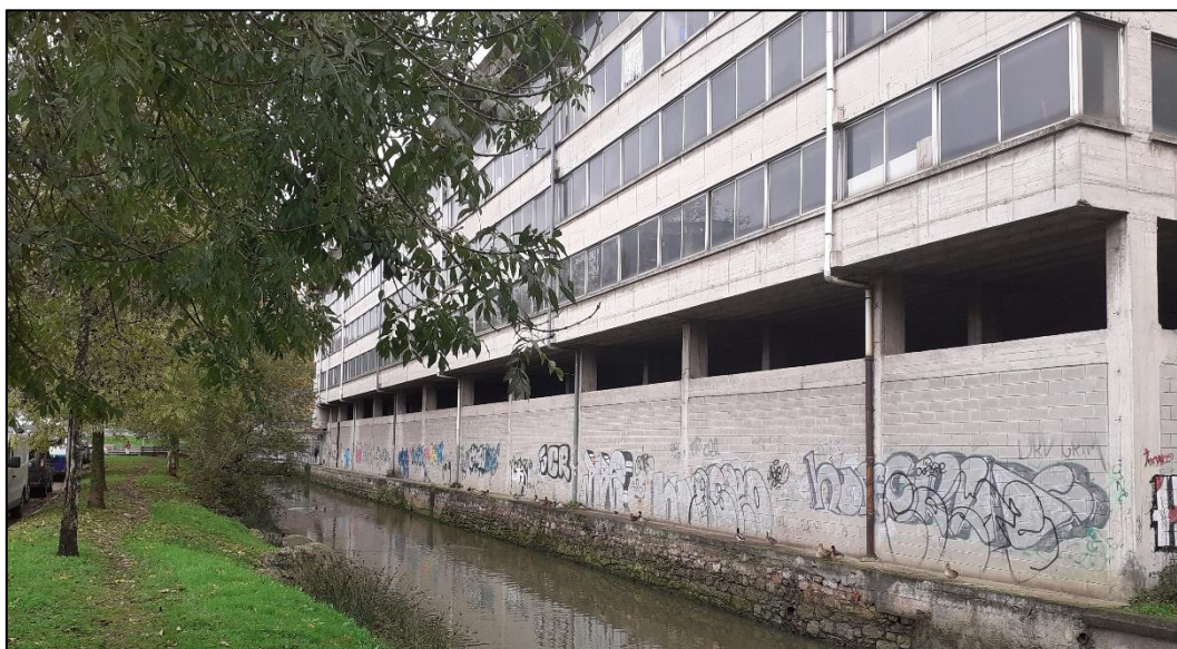
Foto 5. Edificio del ámbito Pavinsa junto al arroyo Molinao
