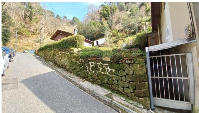
Vista de muros de contención del terreno
